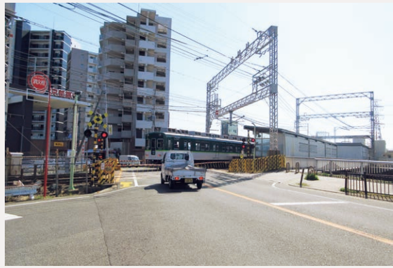
③牧野駅北側の踏切付近
