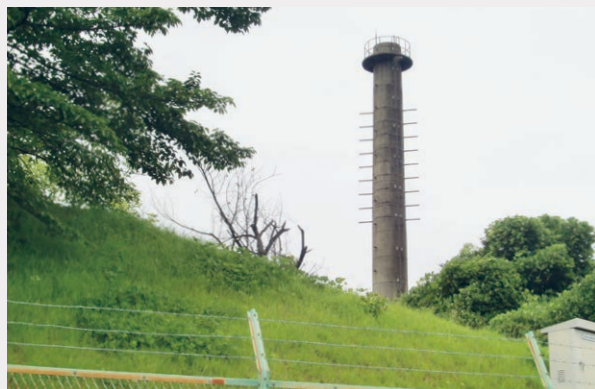
②香里製造所の遺構、天を衝くボイラー用煙突
