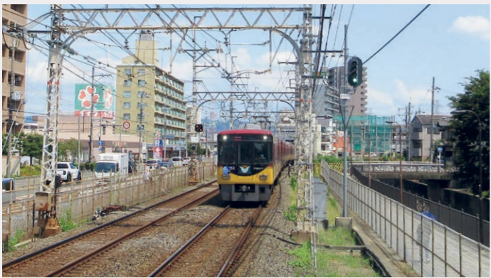
①左側の旧京街道沿いを走る京阪特急、御殿山駅北付近
